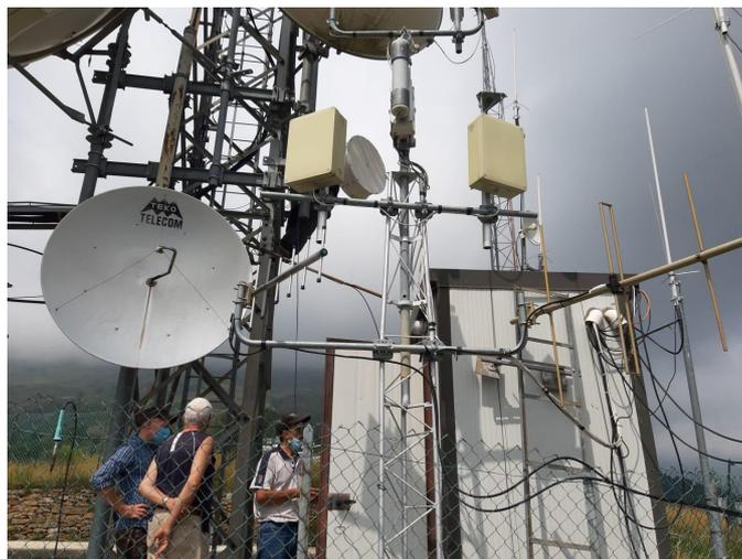
Mentre i nostri cugini di cisaroribie venuti a darci una mano per questa installazione. Installavano e puntavano la parabola noi ci siamo concentrati su la parte elettrica di alimentazione cavi Rf e antenna direttiva attualmente collegata al ripetitore solo come fase di test per questa fase il prossimo step è collegarsi alla rete Nazionale ed esattamente al Link Nazionale fonia cosa che speriamo e ci auguriamo di fare entro breve.
